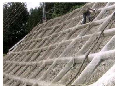
誰でも容易に組み立てられて、鉄筋を確実にホールドします。
