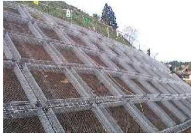
天端の際切り加工と溶接により、安全性と作業性を確保しています。
